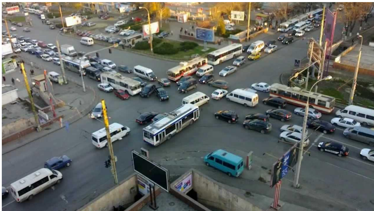
Figura 4: Străzile din Chișinău sunt focusate exclusive pe transportul motorizat și sunt neprietenoase pietonilor, cicliștilor și transportului public.
